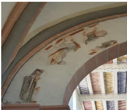
freigelegte Malerei Triumphbogen
